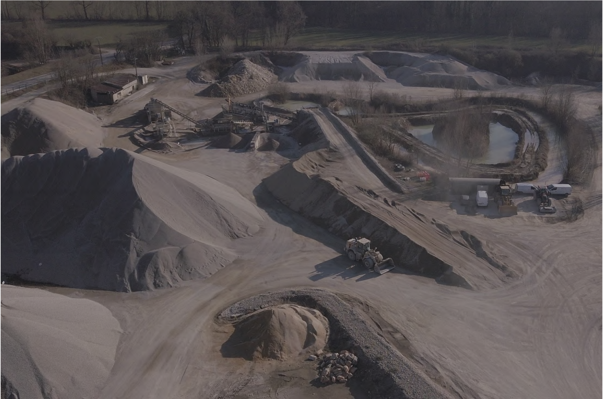
Vue aérienne oblique de l'installation
